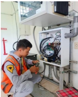
Gambar 7. Proses pemasangan konektor RJ 45
