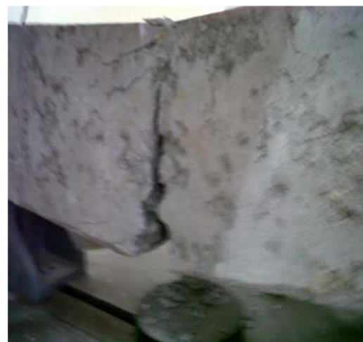
Gambar.5.8 Keruntuhan B.Uji Precastl 2
