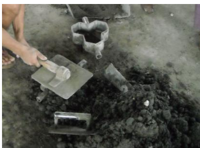
Gambar 3.4: Foto Proses pemadatan adukan paving blok.
