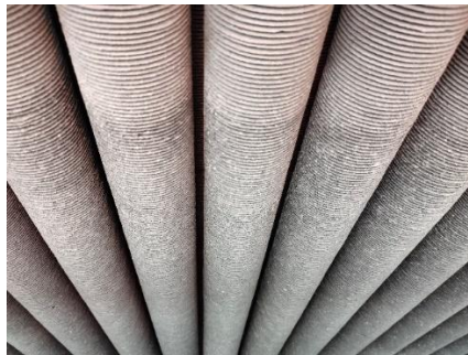
Gambar 1 Kondisi fin-tube kotor
