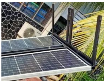
Gambar 8 Sudut kemiringan frame reflektor
