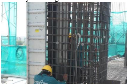
Gambar 4. Kolom K1 untuk Analisis Kekuatan Bekisting Aluko
