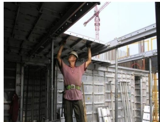
Gambar 1. Bekisting Aluko pada Fritz Tower
