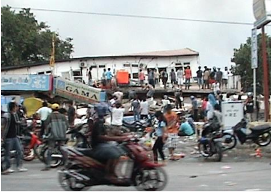
Gambar 2. Kondisi bangunan Bimbel Gama yang runtuh akibat gempa Padang 2009 [4]
