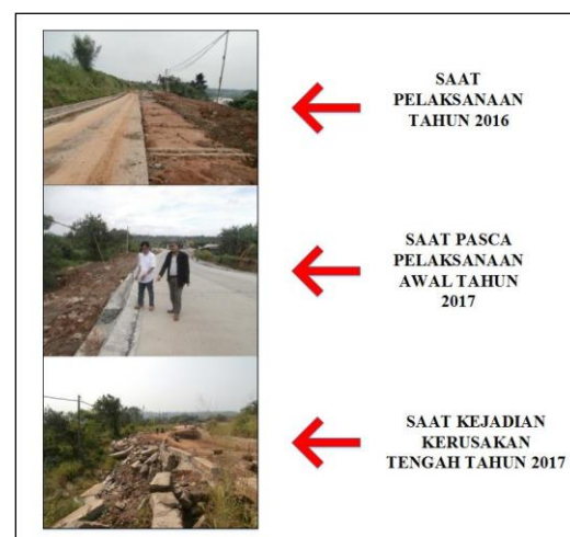
Gambar 3. Kronologis kerusakan badan jalan
