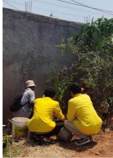
Gambar 3. Penggalian Pondasi untuk Pemasangan Tiang PJU TS
