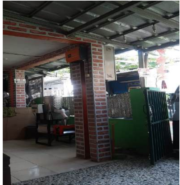
Gambar 4. Proses Pemasangan PLTS dan alat pengupas pengiris bawang otomatis
