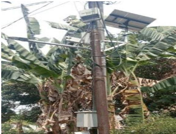
Gambar 6. Proses pemasangan PJU-PLTS pada GG masdik perbatasan RT 06 dan RT.05/07
