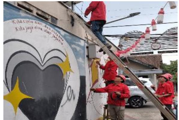
Gambar 4. Proses pemasangan PJU-PLTS pada Gerbang cagar budaya RT.01/07
