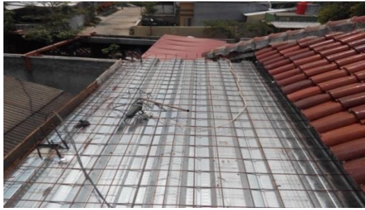
Gambar 5. Bondek dan wiremesh atap
