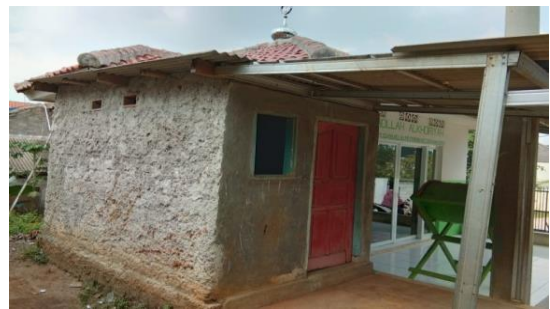
Gambar 2. Tampak bangunan eksisting yang akan di renovasi
