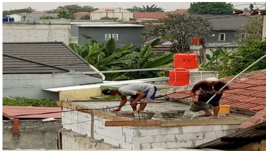
Gambar 7. Pelaksanaan pengecoran atap dek
