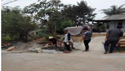
Gambar 6. Pembuatan campuran beton dek
