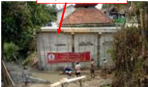
Gambar 3. Atap cor beton bertulang
