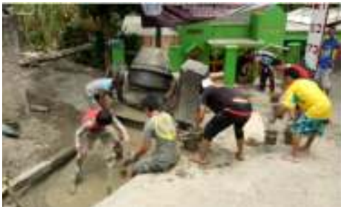
Gambar 4. Pengecoran menggunakan molen
