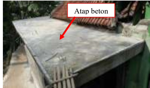
Gambar 5. Atap cor beton bertulang Pekerjaan perbaikan atap berupa beton bertulang wiremesh dan bondex sampai akhir bulan November 2018 sudah selesai.
