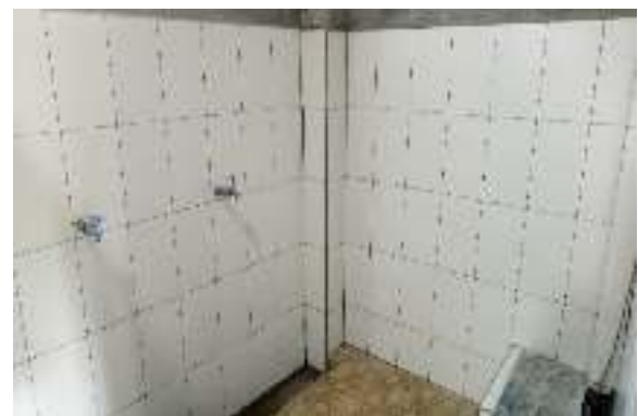
Gambar 19. Keramik dinding tempat wudhu dan toilet sudah terpasang
