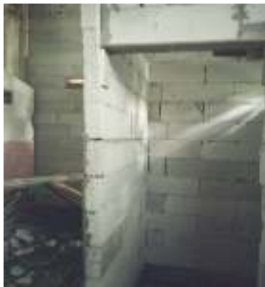
Gambar 16. Pintu toilet belum terpasang
