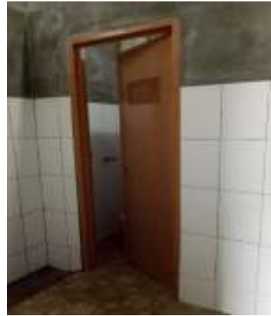
Gambar 17b. Penggantian 2 unit pintu kamar mandi sudah terpasang
