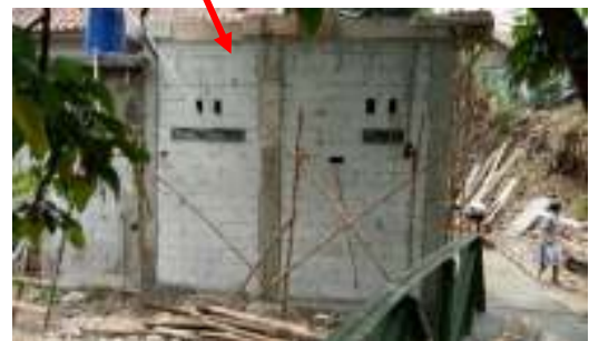
Gambar 7. Pemasangan dinding baru sisi belakang
