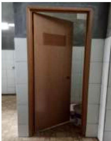
Gambar 17a. Penggantian 2 unit pintu kamar mandi sudah terpasang
