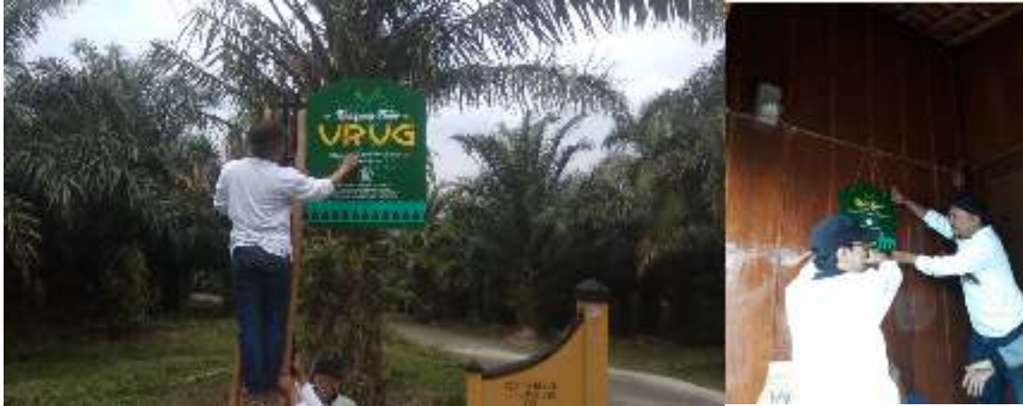
Pemasangan sign system di jalan utama dan di rumah adat
