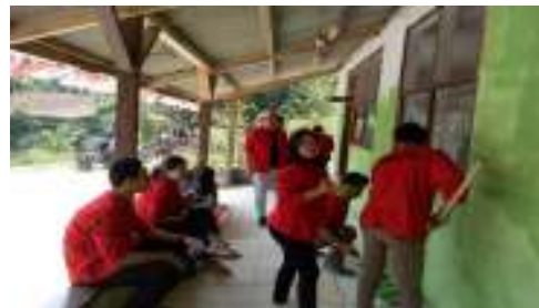
Gambar 4.4 Pekerjaan Dinding kelas
