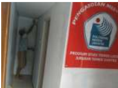
Gambar 4.2 Pekerjaan WC, Selesai
