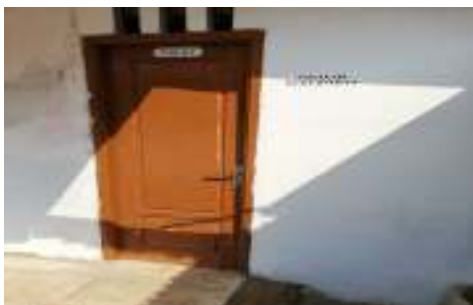
Gambar 4.10 Pintu Toilet Selesai
