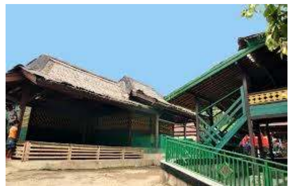
Gambar 2. Bangunan Rumah Gedong Di Kampung Urug
