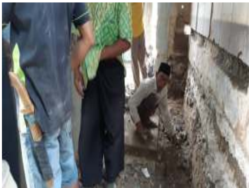
Gambar 4a. Pengerjaan Pondasi.
