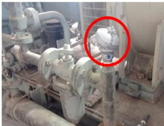
Gambar 3 Pemasangan Sensor Suhu Pada Turbin
