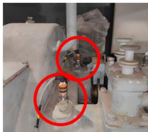
Gambar 4 Pemasangan Sensor Getaran Pada Turbin
