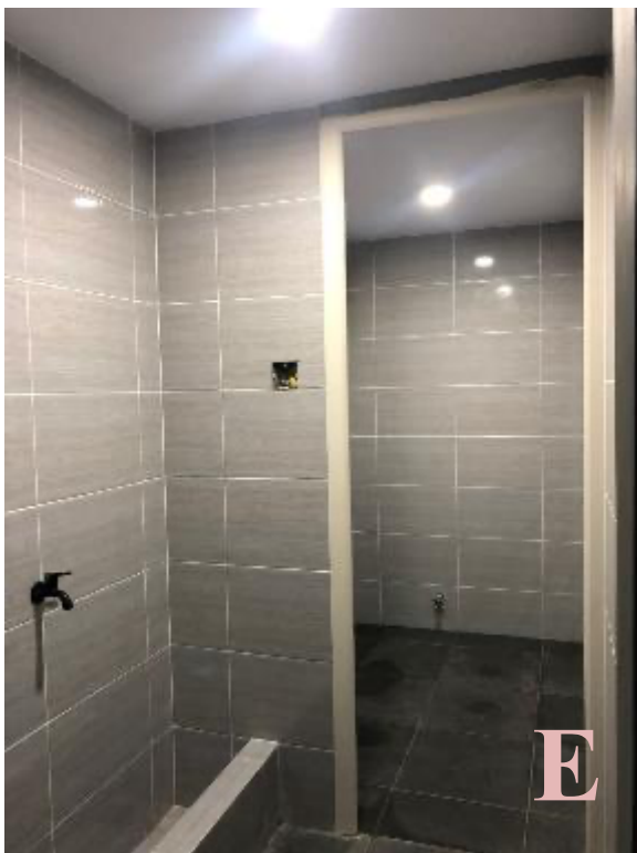
Gambar 3. E. Tampak Ruang wudhu setelah selesai dibangun
