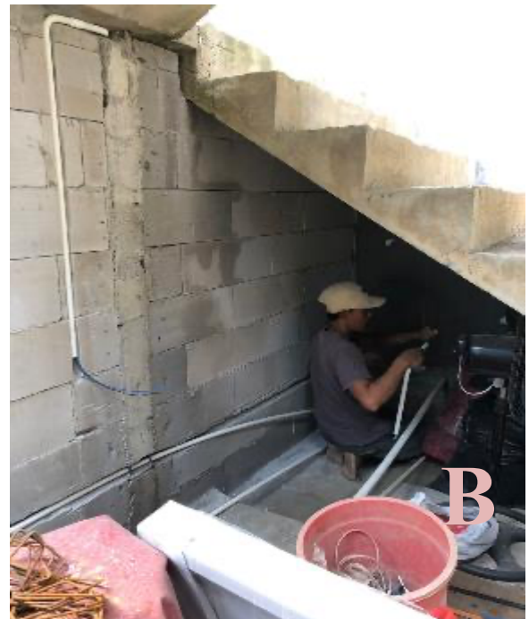
Gambar 3. B. Proses pemasangan pipa dan pompa
