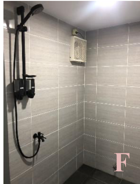
Gambar 3. F. Tampak dalam kamar mandi setelah selesai dibangun
