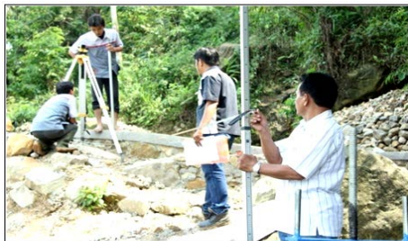
Gambar 2 Pengukuran ketinggian jatuh air sungai Ciasihan
